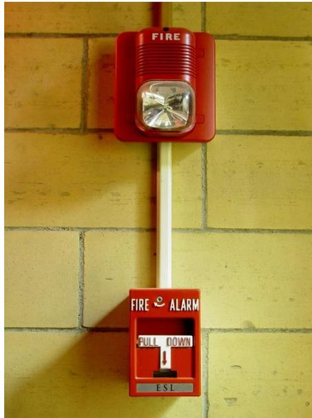
*Figura 1 - Instalación típica de estación manual con combo de sirena y luz estroboscópica*
